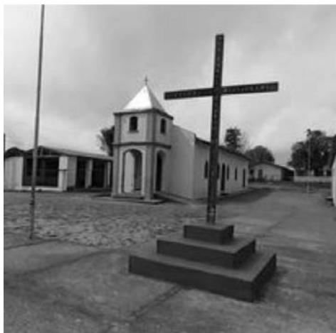
A Capela de Nossa Senhora da Guia, do Bairro do Taquaral Abaixo, em fotos do autor.
